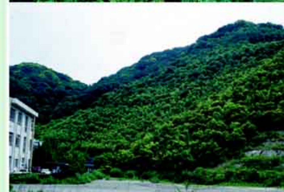
久里浜高校裏の防災環境保全林。上から順に、施工時、植栽時、2年目、3年目、10年目の様子。
