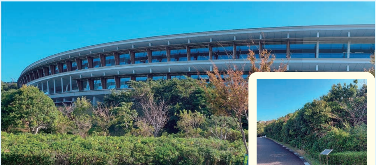
IGES 本部の建物外観
